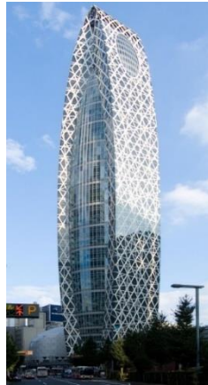
شكل (26): تصميم مبنى مستوحى من شكل الشرنقة البيضاوي في الجزء الخارجي مع دخول الواجهة الأمامية بالإضافة إلى إichاءات تداخل الخيوط الحريرية المكونة لها لتشكيل الفراغات الهندسية المدروسة وتوظيفها بشكل سليم للتكيف مع الرياح التي تصطدم بأعلى المبنى.
