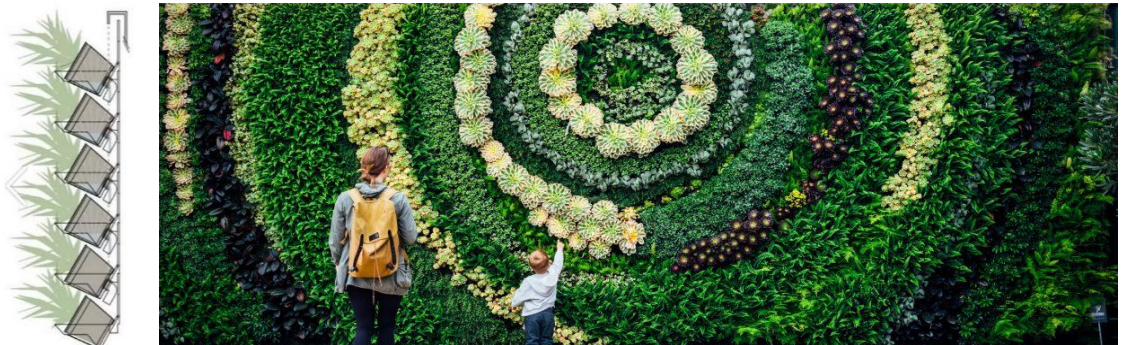
شكل (3) يوضح أنظمة الألواح أو الوحدات النمطية التي تزرع بها النباتات مسبقاً والتي يمكن استخدامها داخلياً وخرجياً في جميع الظروف
